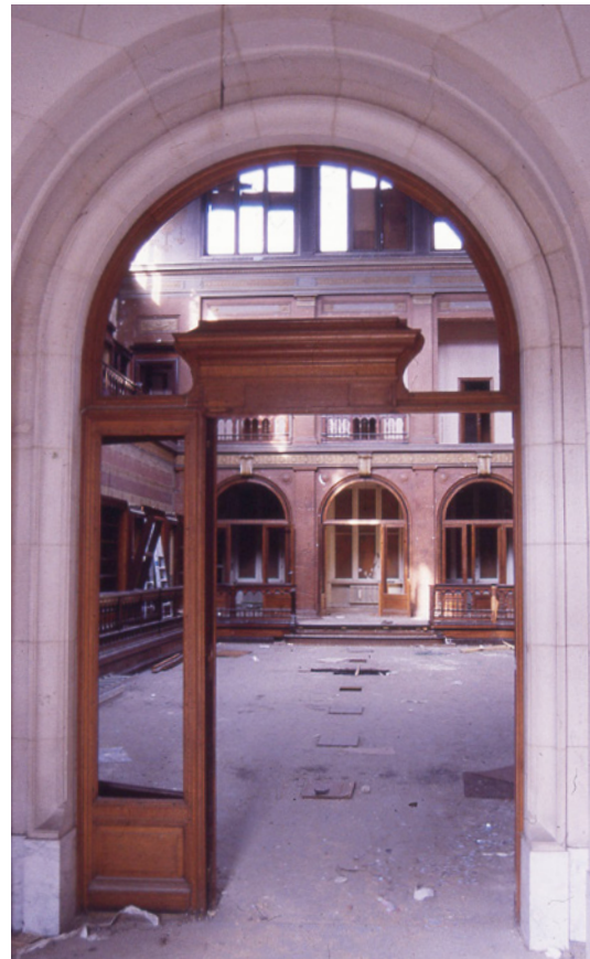
DE SOLVAYBIBLIOTHEEK IN HET LEOPOLDSPARK, VOOR DE RENOVATIE IN DE JAREN 1990, ZIE 7
