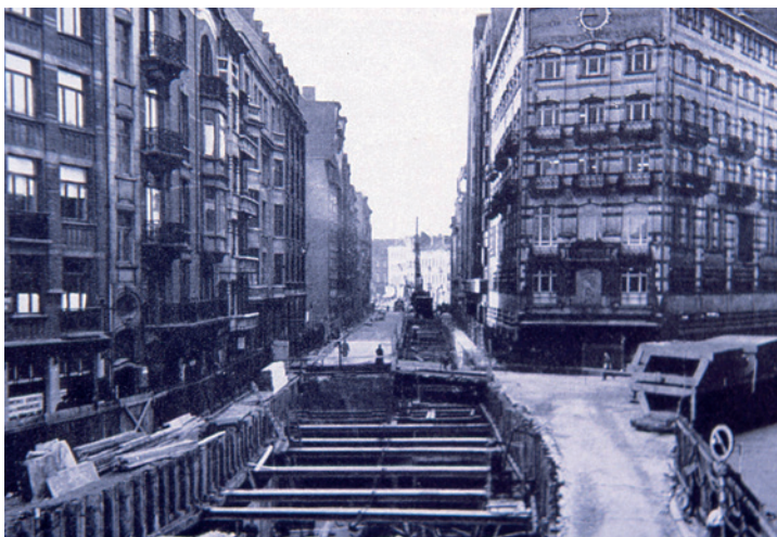
LUCHTVAARTSQUARE, AANLEG ZENNERIOOL (1957), ZIE 4 EN 5
