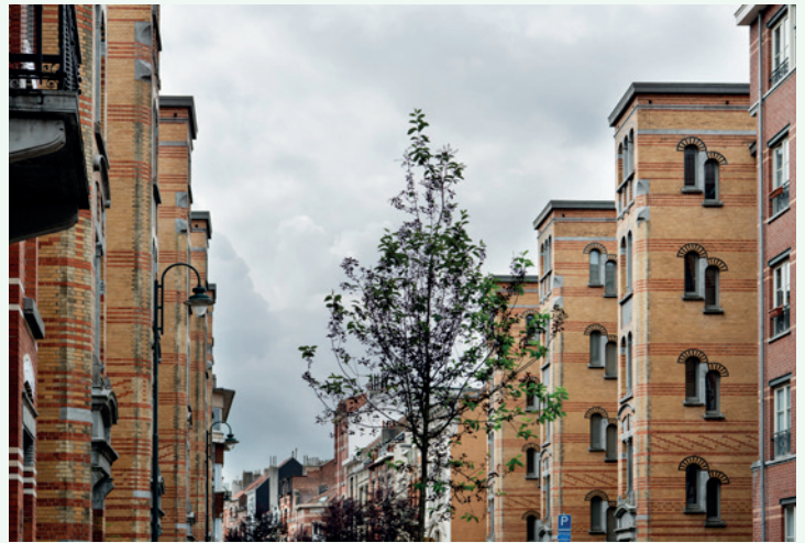
SOCIALE WONINGEN RODENBACHSTRAAT
